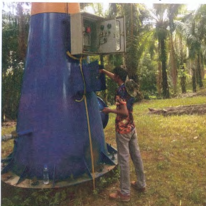
โครงการซ่อมประปาทุ่งค้อ หมู่ 2 บ้านใหม่สมบุรณ์
